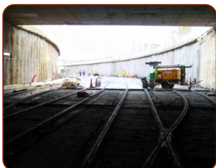
La salida del túnel de Colonia Jardín hacia Pozuelo y Boadilla, desde su conexión con la línea 10 de Metro Madrid
