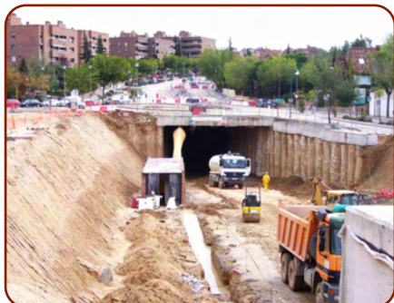
La entrada del túnel de la Avenida Comunidad de Madrid en fase final de excavación
