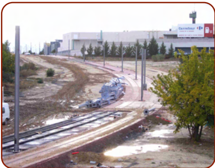
Vía de acceso de la línea hacia Boadilla que presta servicio a Ciudad de la Imagen. Ofrecerá tres estaciones: una en el Centro Comercial, otra en Telemadrid y la última en la zona de ocio (restaurantes y cines)
