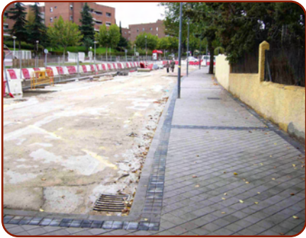
Las aceras de la Avenida Comunidad de Madrid, más anchas que antes
