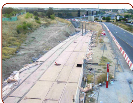
En la zona de La Finca ya podemos ver la plataforma acabada con un color de tipo "tierra" y los trabajos de electrificación que están empezando
