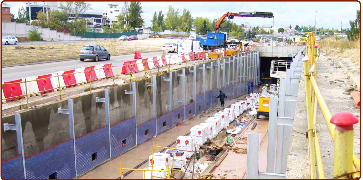
Entrada del túnel en la zona de la parada de Colonia Los Ángeles.
